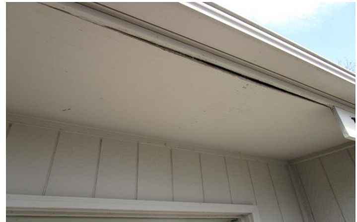
Loose soffit
